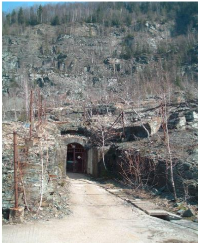
a) Inainte de modernizare
