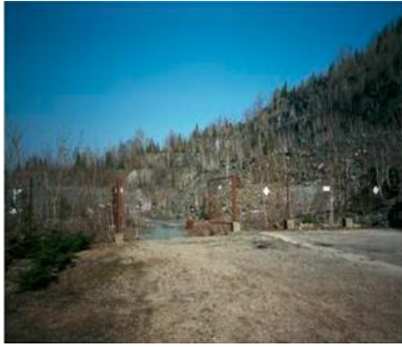
a) Inainte de modernizare
