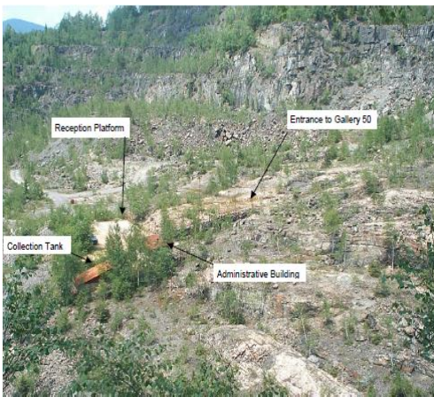
a) Inainte de modernizare
