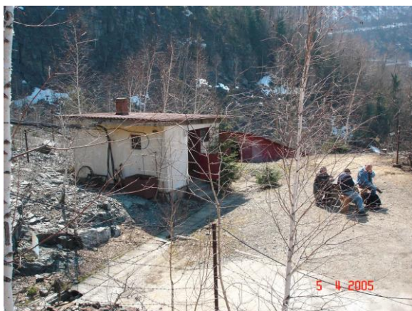
a) Înainte de modernizare
